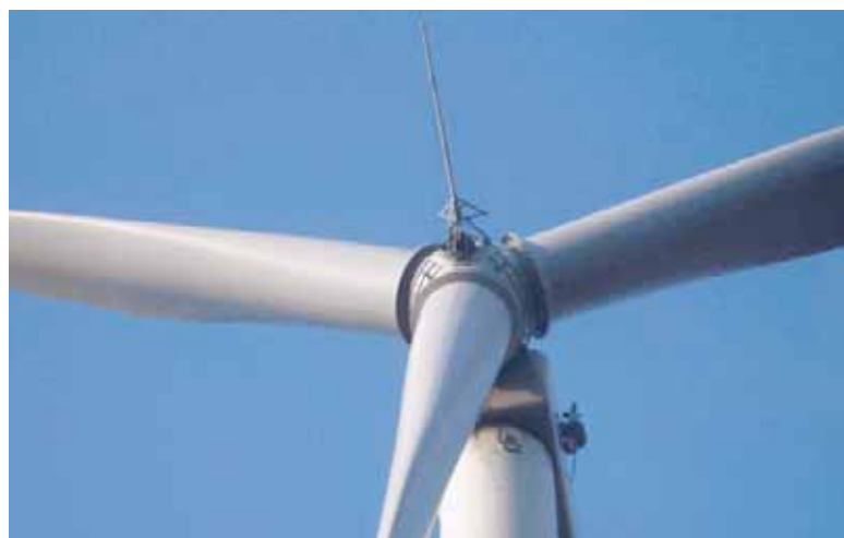
Abb.: Windenergieanlage mit montiertem Erfassungstool
