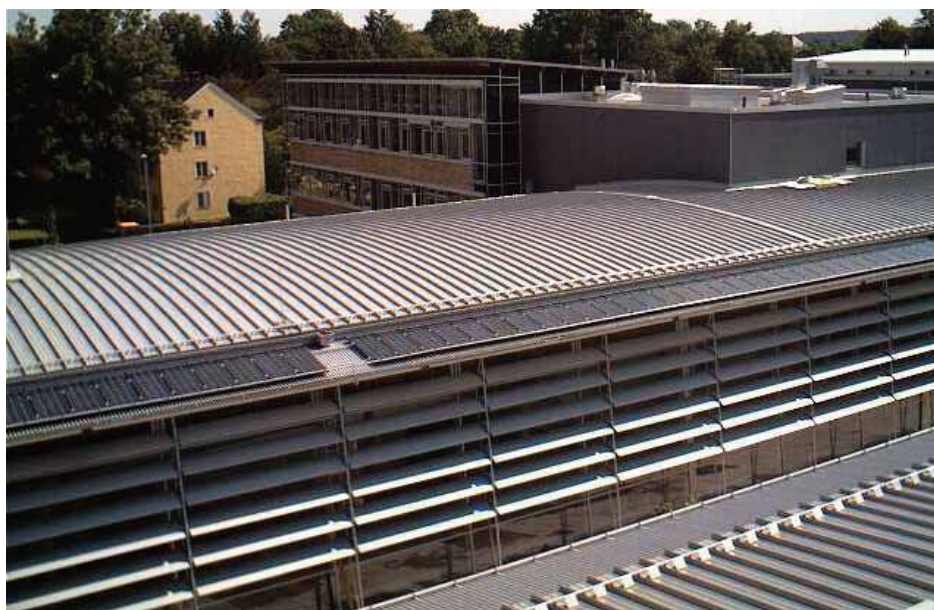
Blick auf einen Teil vom neu errichteten S-Bau (Bild von der Webcam der Hochschule Rosenheim unter http://elron.fh-rosenheim.de/mobotix/archiv )
